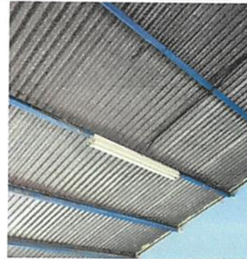
Foto 4: Sustitución de plafoneras, tomacorrientes y apagadores
